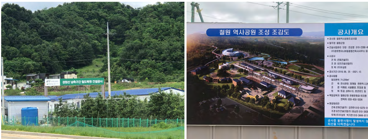
그림 21. 경원선과 철원역사공원 공사 현장
