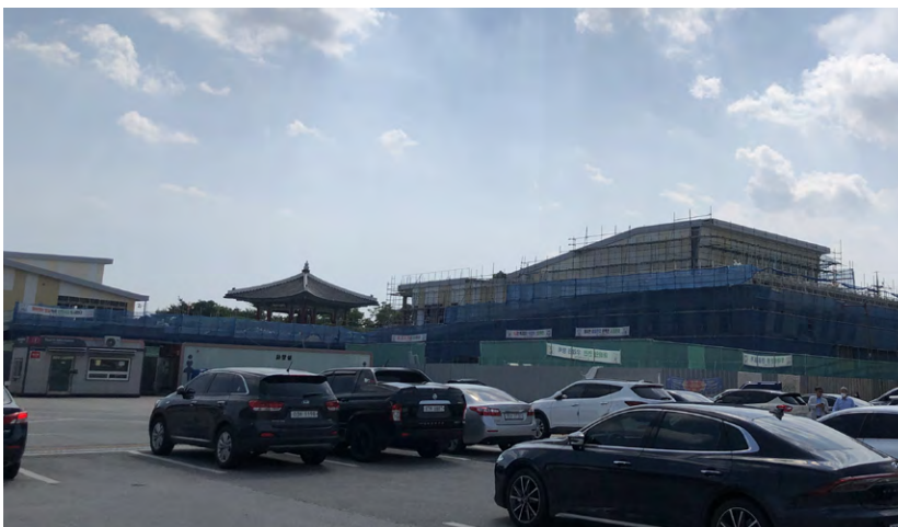
그림 28. 파주 임진각 평화센터 신규 공사현장
